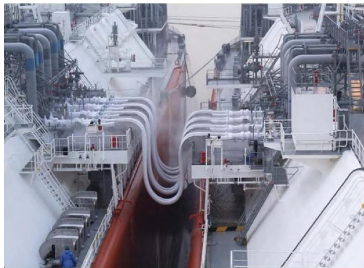
Figure 8.2.1 STS transfer of LNG carriers
